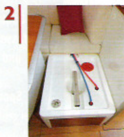
2 Tanklager. Um Teile und Gewicht zu sparen, dienen die Frischwassertanks als Unterbau fürs Sofa. Die Polster liegen direkt auf
